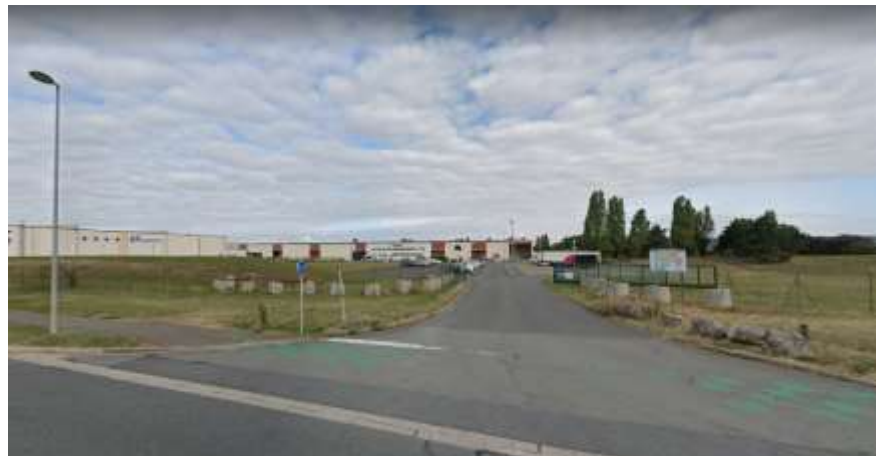
Vue éloignée depuis l'entrée située rue du Paradis –septembre 2019 (source : google)
