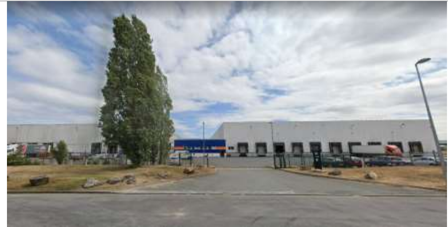
Vue éloignée depuis l'entrée située rue des Sablons –août 2019 (source : google)
