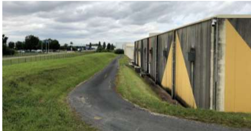
Vue rapprochée depuis l'angle Sud du parc logistique –août 2021
