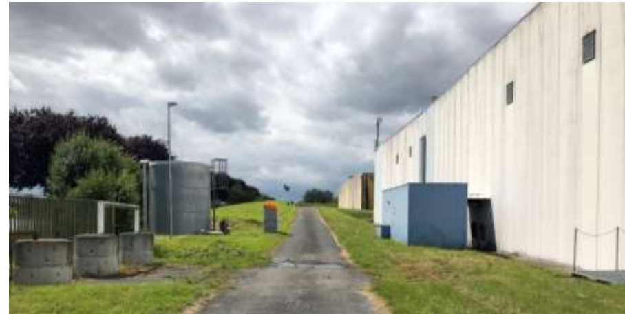
Vue rapprochée depuis l'arrière de Ormes 2 et Ormes 3 –août 2021
